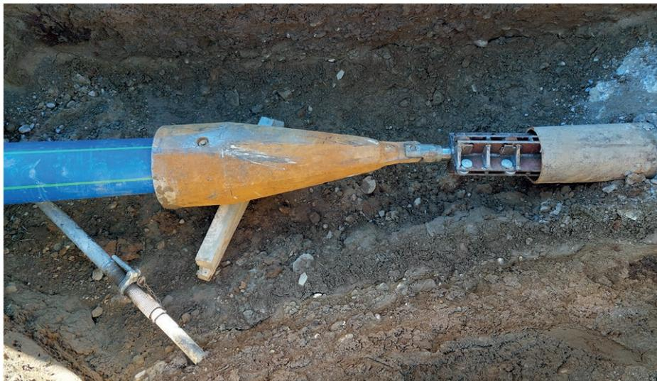
Das neue Rohr wird mit dem Berstkörper voran in die defekte Leitung gezogen.
